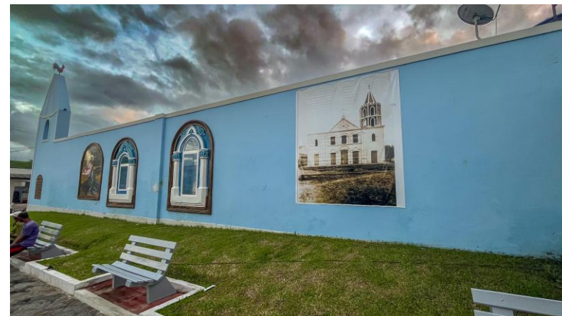
Em 2024 a Prefeita Angela Vanessa restaurou a única parede que restou da antiga Igreja de São José em parceria com Carajás home center e Tintas Coral .
